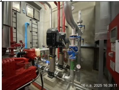
รูปที่ ฃ7.48 เครื่องสูบน้ำดับเพลิง
