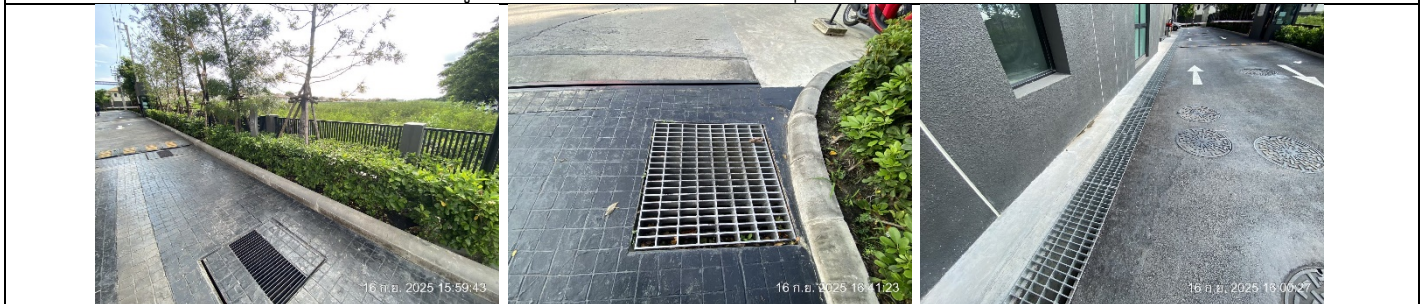
รูปที่ ผ7.72 ตะแกรงครอบคลุมรูท่อระบายน้ำ
