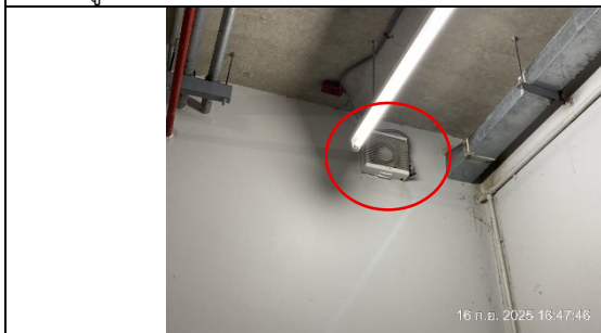
รูปที่ ผ7.16 พัดลมดูดอากาศ ห้องพักมูลฝอยเปียก
