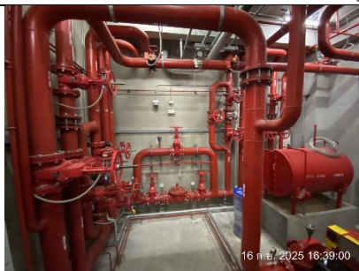
รูปที่ ฃ7.49 ระบบท่อยืน (Stand pipe system)
