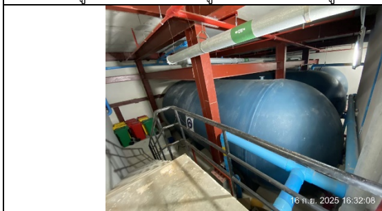
รูปที่ ผ7.18 ถังเก็บน้ำชั้นหลังคา
